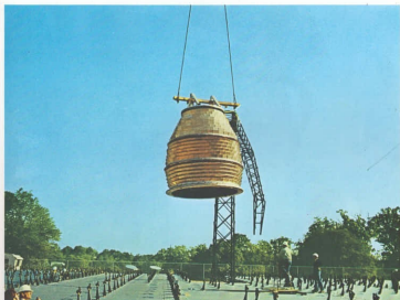
Ansaldo: montaggio della caldaia solare fornita al Georgia Institute of Technology di Atlanta negli Stati Uniti
