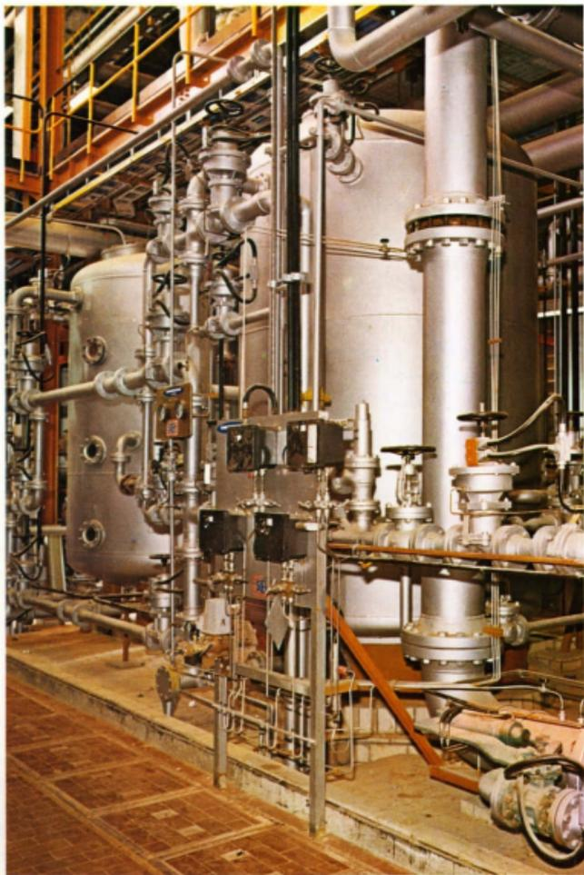
Particolare di un impianto per il trattamento « condensato a letti misti » delle acque industriali realizzato dalla Termomeccanica Italiana.
