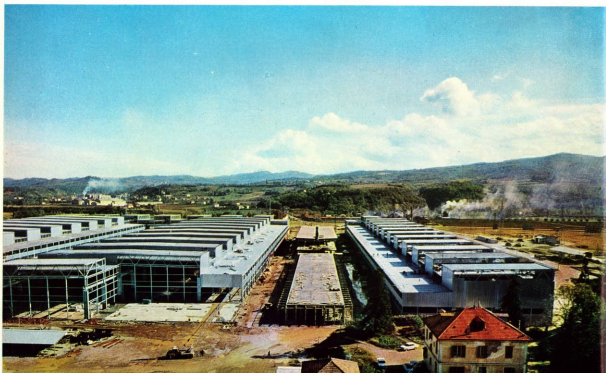
Delta - Società Metallurgica Ligure, Genova. Il nuovo grande stabilimento in fase di avanzata costruzione a Serravalle Scrivia, dove nel prossimo anno verranno gradualmente trasferite le lavorazioni dall'attuale sede di Genova Cornigliano.
