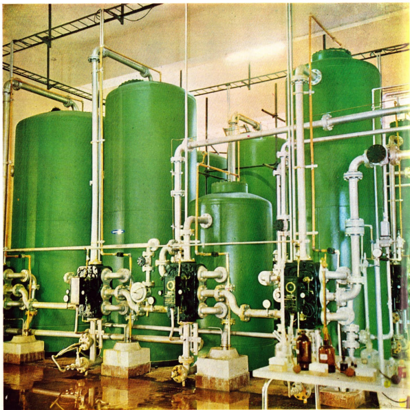
Termomeccanica Italiana, La Spezia. Lo stabilimento ha in corso importanti lavori di ammodernamento. Nella foto: particolare di impianto Cochrane di addolcimento e demineralizzazione dell'acqua per alimento caldaie e di depurazione del condensato.
