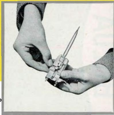
Alle Läufe können untereinander ausgetauscht werden. Ohne dass vorher eine Änderung durchzuführen ist, können sie in das automatische Breda-Gewehr desselben Kalibers eingebaut werden (Abb. 3).
